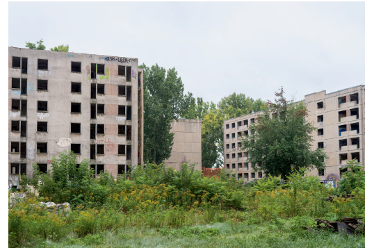
Sung Tieu, Documentation of Gehrensee-strasse, 2025./ Sung Tieu, Dokumentation der Gehrensee-strasse, 2025.
