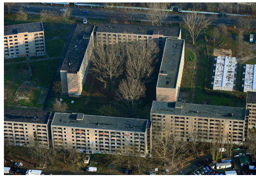
Aerial view of the vacant, gutted residential blocks, circa 2010./ Luftansicht der leerstehenden, entkernten Wohnblöcke, circa 2010.
