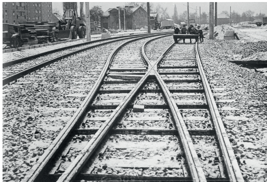
Track laying for the new tram line on Rhinstrasse, with the GDR contract workers' housing complex visible nearby, 1984./ Gleisbauarbeiten für die neue Straßenbahnverbindung an der Rhinstrasse; im Hintergrund die DDR-Vertragsarbeiter*innenwohnheime, 1984.
